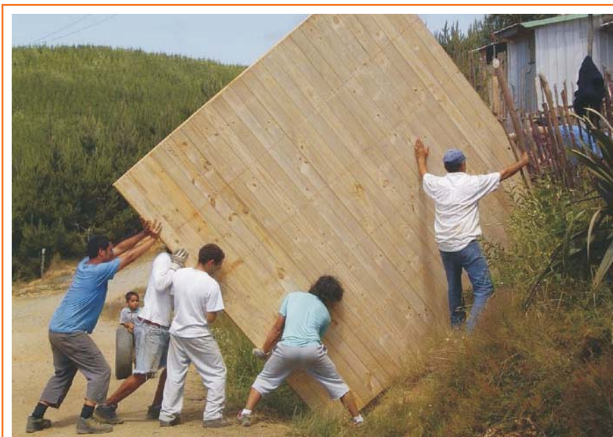
Alcuni di quelli coinvolti nella costruzione di case e nella sistemazione di quelle già esistenti, rendendole case abitabili. L'immagine è concessa gentilmente da Un Techo para Chile.
